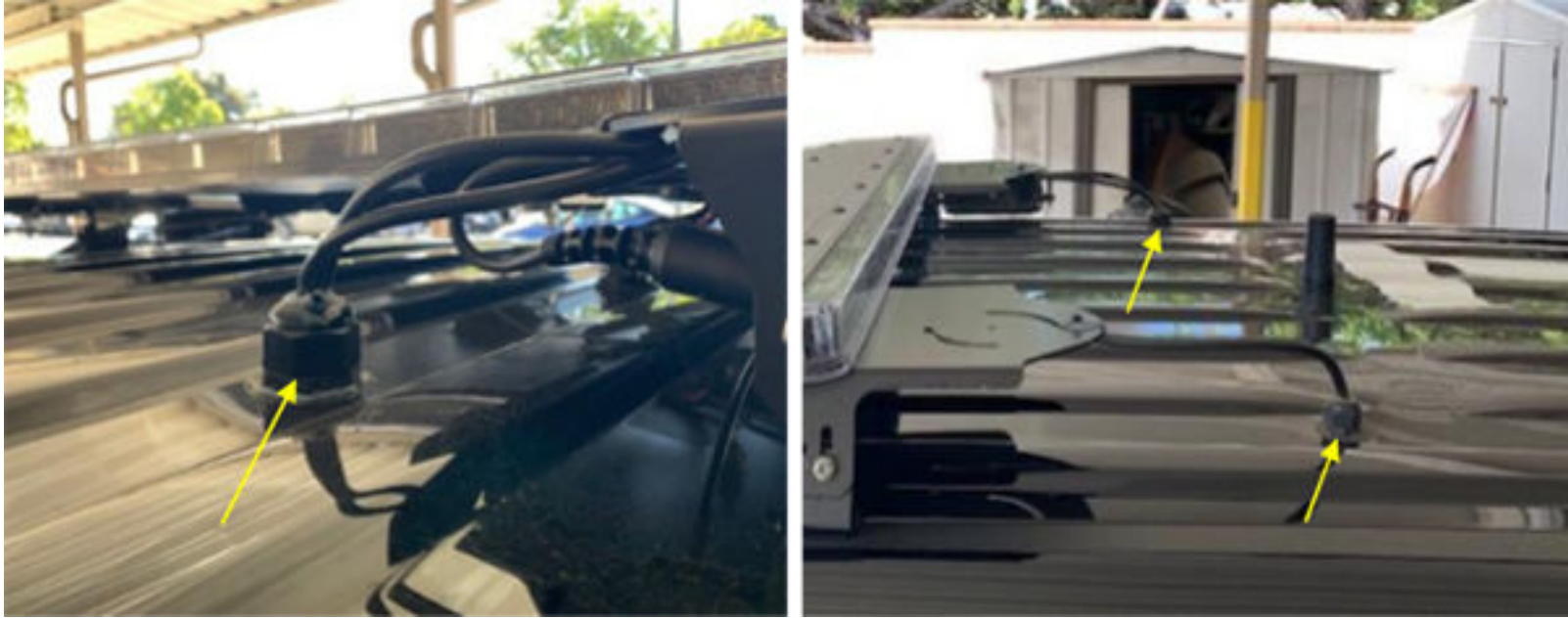
Figure 16 : Acheminement des câbles dans les trous du toit
