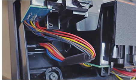
Figura 28: Remoção do cabo de cada encaixe de compartimento
